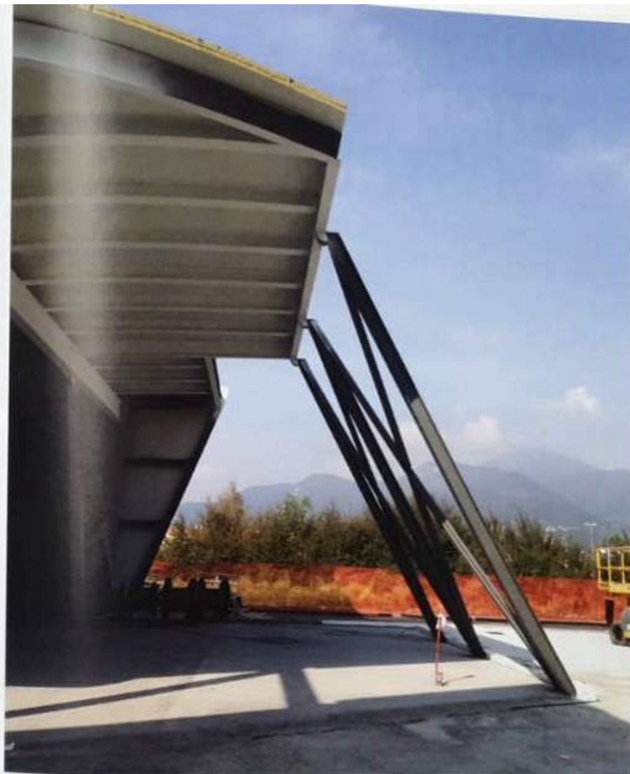
Vista degli elementi metallici portanti e dei controventi in carpenteria metallica.
